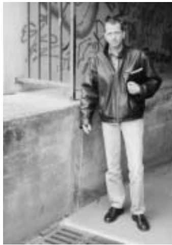
Wurde behoben: Holperkante an der Bahnunterführung
